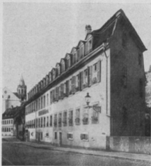
Neumanns Wohnhaus in der Burkarderstraße zu Würzburg
