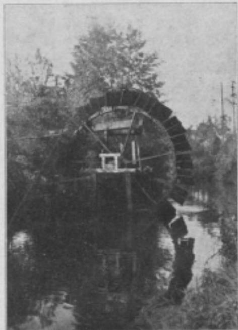
Das sog. Zwerch-Schöpfkräder in einem Nebenarm der Pegnitz an den Werkern bei Erlangen
