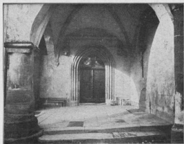
Borhalle der Südseite
