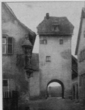
Sulzfeld. Zalterturm von innen.
